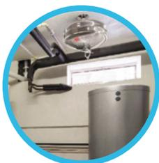
Модуль пожаротушения подвесной МУП BONTEL представляет собой высокоэффективную установку пожаротушения, заправленную жидкостным огнетушащим составом BONTEL. Подвесной модуль предназначен для защиты помещений производственного и хозяйственного назначения, применения на транспорте и в бытовых условиях в качестве средства тушения пожаров классов «А» (твердых горючих веществ), «В» (жидких горючих веществ) и «С» (газов).
